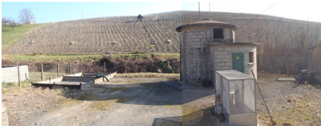
Vue générale de la station d'épuration de Jullié
