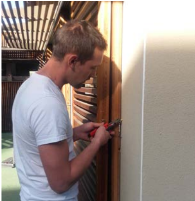
Pose de crochets pour maintenir les volets de Patati
