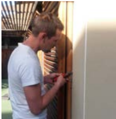
Pose de crochets pour maintenir les volets de Patati
