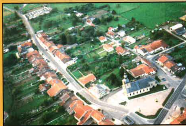
Vue aérienne (photo : Club ULM).
