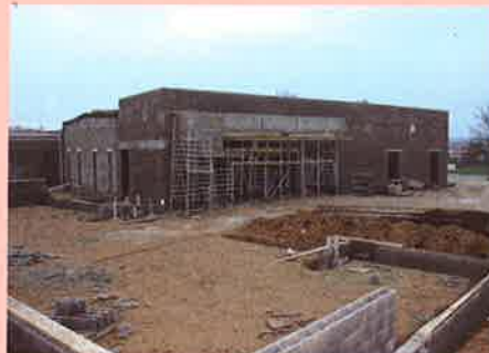
Travaux du côté de la cantine
