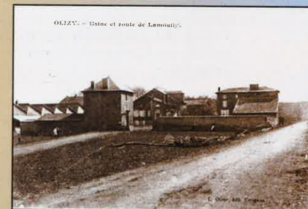
OLIZY - Usine et route de Lamouilly. d'hui, un seul bâtiment rappelle le souvenir Vue de l'ancienne fonderie.
