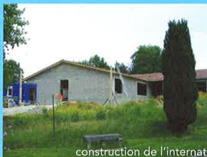
construction de l'internat
