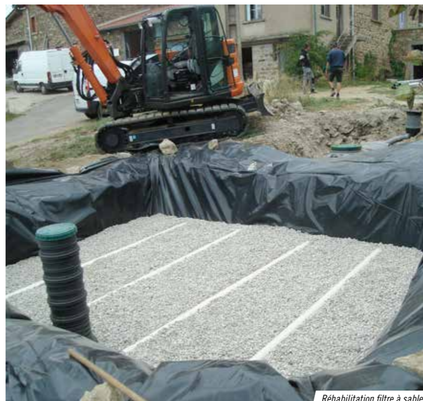
Réhabilitation filtre à sable
