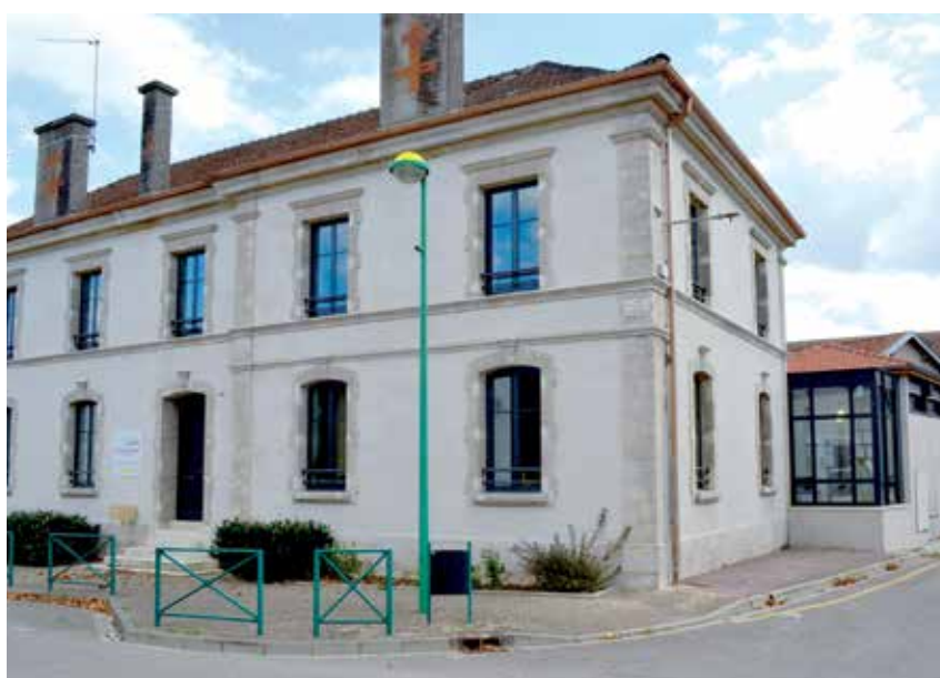
Bureaux côté rue Poincaré
