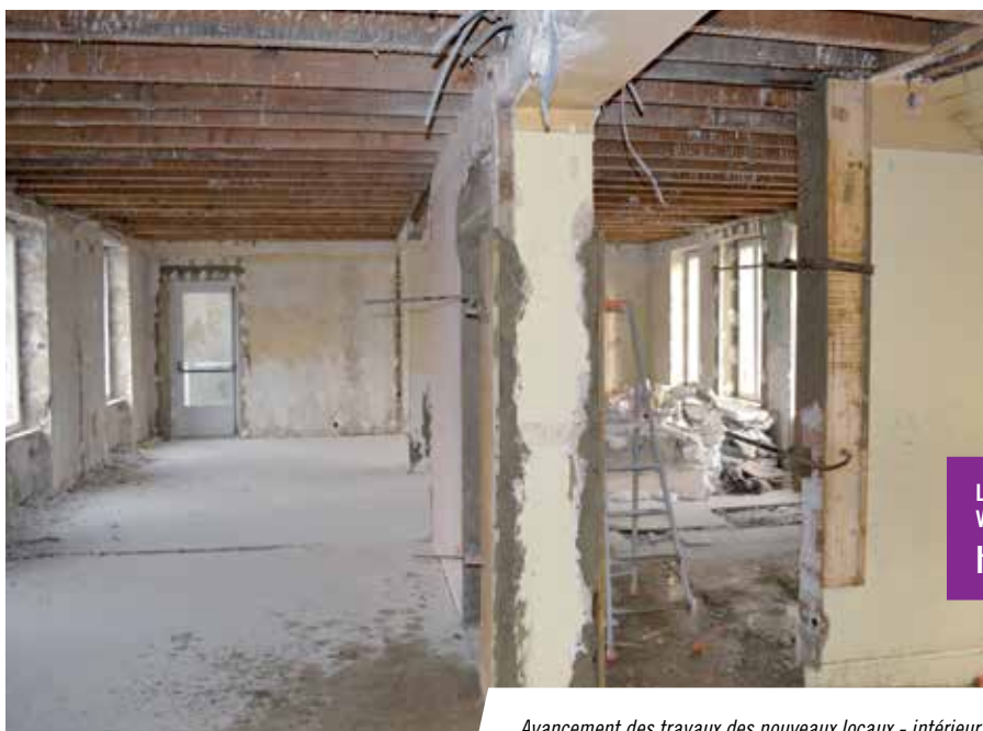
Avancement des travaux des nouveaux locaux - intérieur.
