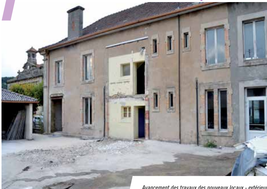
Avancement des travaux des nouveaux locaux - extérieur
