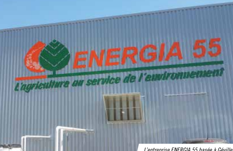
L'entreprise ENERZIA 55 basée à Géville.
