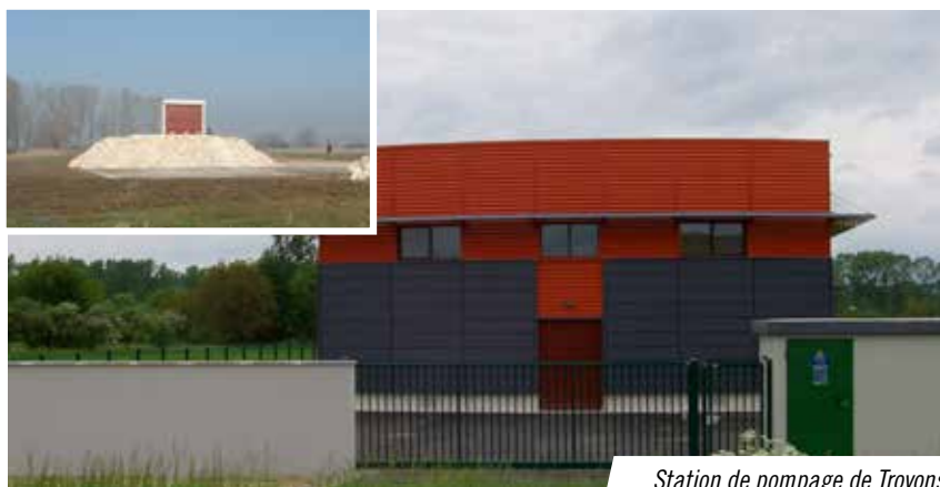
Station de pompage de Troyons
