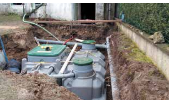
Lestage d'une microstation car présence de source en fond de fouille
