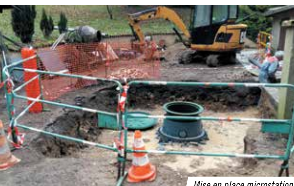
Mise en place microstation
