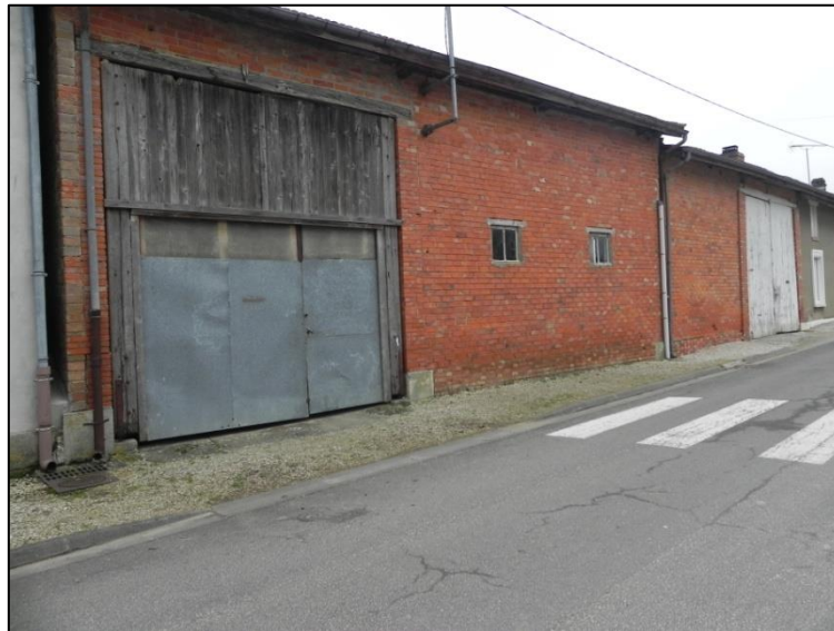
Exemple d'habitation vacante Source : TOPOS
