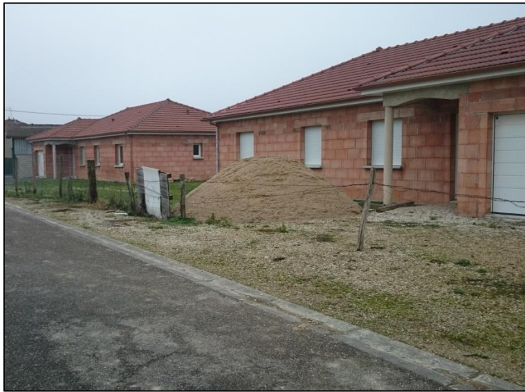
Constructions récentes rue Merdrée
