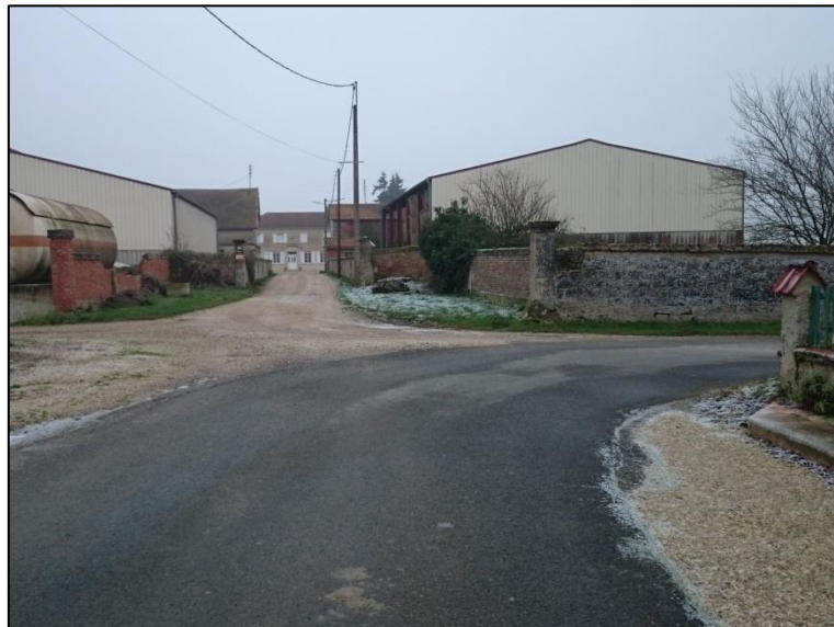
Bâti agricole rue des Trois Bûchettes (D59E1) Source : TOPOS
