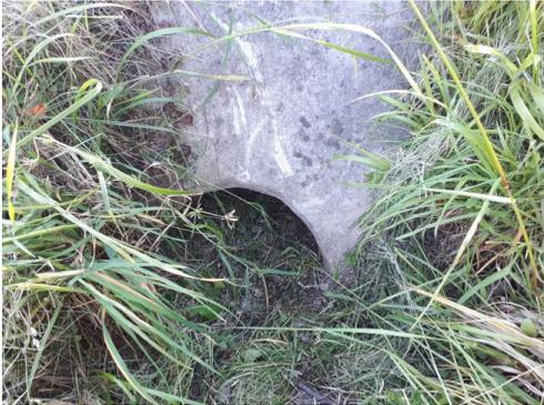
Buse diamètre 400 mm sous l'entrée du site
