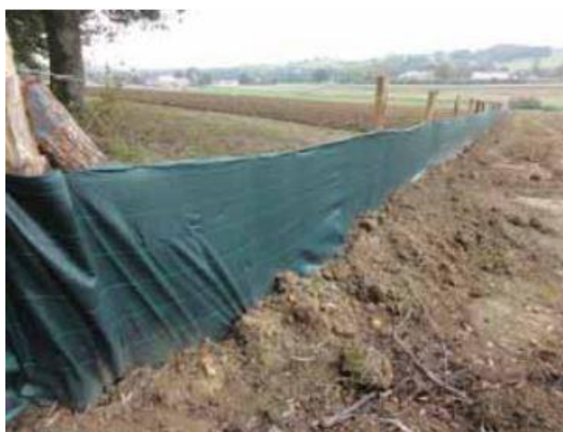
Photo 2 : Exemple de barrière anti-intrusion
