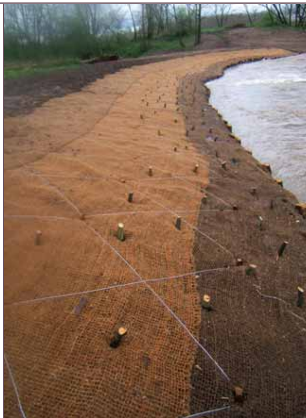
Armature en fil galvanisé du talus aménagé
