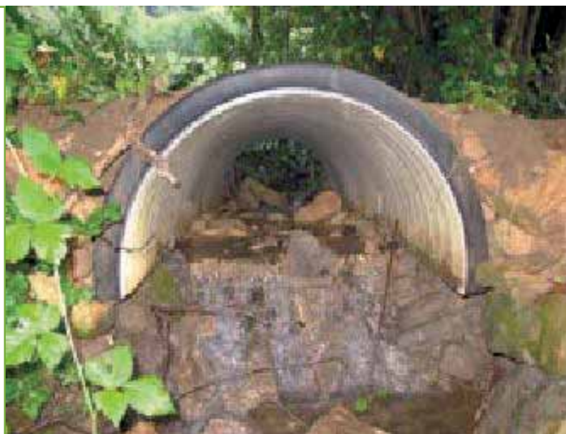
L'accélération de l'eau liée ici au sous-dimensionnement de l'arche a causé son ensablement, son comblement et une érosion à l'aval
