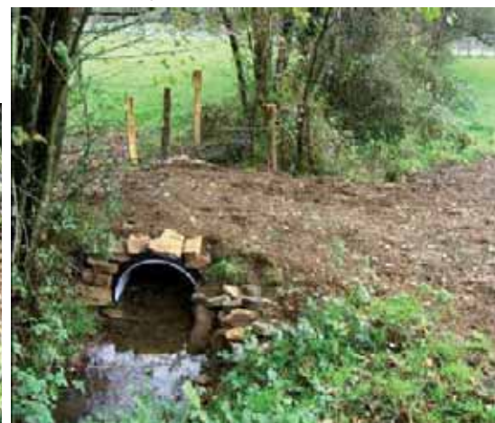
Passage en PEHD terminée
