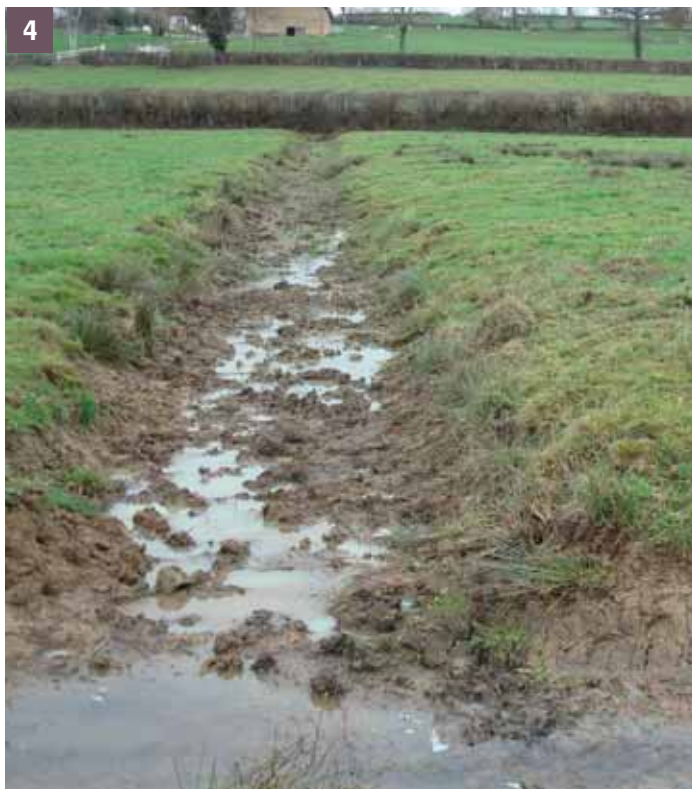
3 et 4 Amenée du drain directement au ruisseau : les sédiments et particules fines sont directement lessivés et apportés sans filtration naturelle au ruisseau qui, de par sa dégradation, a tendance, lui-même, à ressembler au fur et à mesure à un fossé. De plus, les rigoles ne sont pas protégées de l'accès du bétail qui, par son piétinement, aura tendance à rapidement les combler
