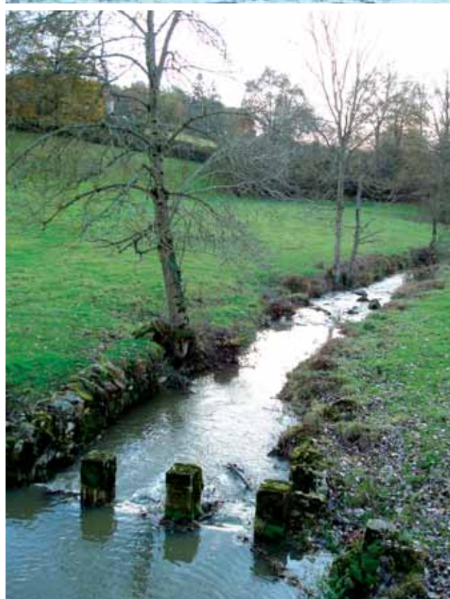
Ancien seuil pour la fertilisation des prés à Ligny en Brionnais
