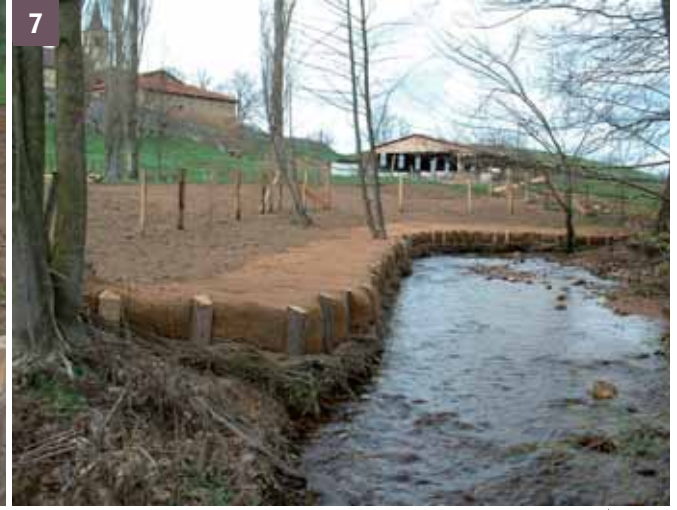
6 et 7 Physionomie de l'aménagement à la fin des travaux. Remarquez la technique qui est bien ancrée dans le talus en amont et en aval ramilles tournées vers l'aval
