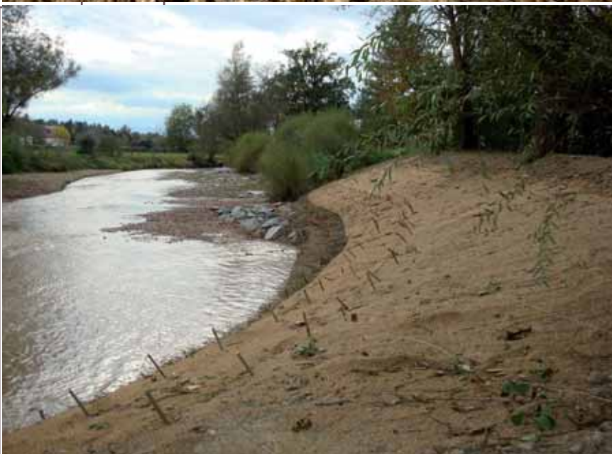
Vue d'ensemble d'une berge fraîchement travaillée et entièrement recouverte/protégée au moyen de treillis de géotextile biodégradable de type coco tissé
