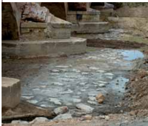
Enrochement percolé de béton de tout le radier du pont lors d'une restauration
