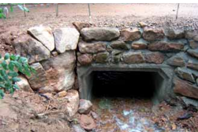
Reconstitution d'un fond naturel à l'intérieur de l'ouvrage
