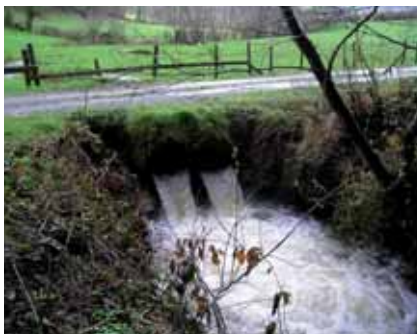
Accélération de l'écoulement = érosion des berges en aval et blocage des espèces aquatiques
