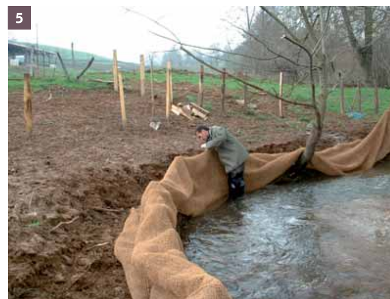
5 Mise en place du lé de géotextile
