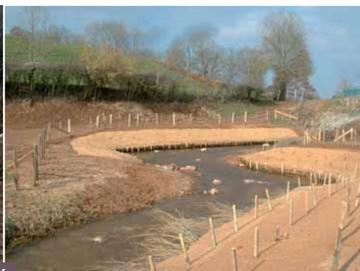
4 Mises en œuvre successives des couches de branches de saules et de matériaux terreux, base des branches en terre et extrémité des ramilles dirigées vers l'aval
