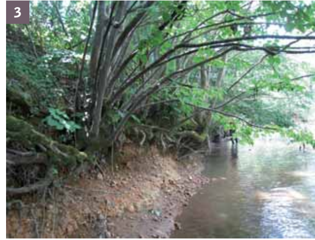
3 Enfoncement à l'aval du lit d'un cours d'eau occasionné par le blocage des alluvions à l'amont d'un ouvrage
