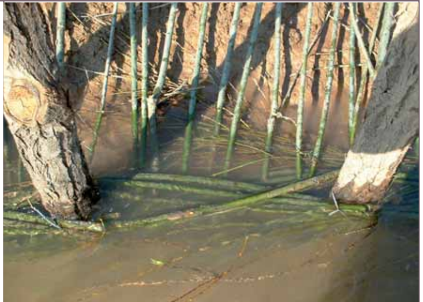
Association du lit de branches ici avec un tressage en pied de berge
