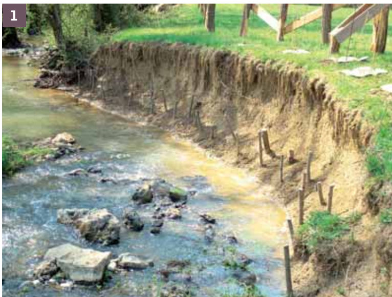
1 Bouturage sur encoche d'érosion
