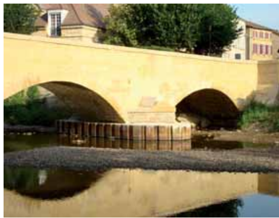
Vue des sédiments exondés à l'étiage en amont du pont
