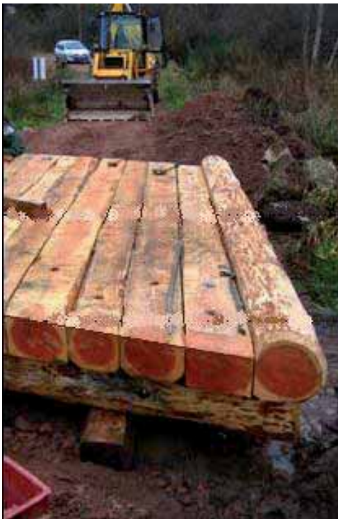
Passerelle en bois en phase de conception
