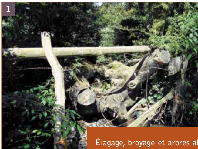
1 Coupe des arbres sans se soucier de la souche versée qui obstrue complètement les écoulements
