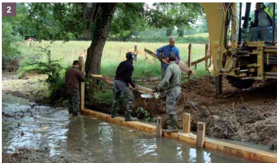
2 Terrassement, mise en place des longrines et des pieux
