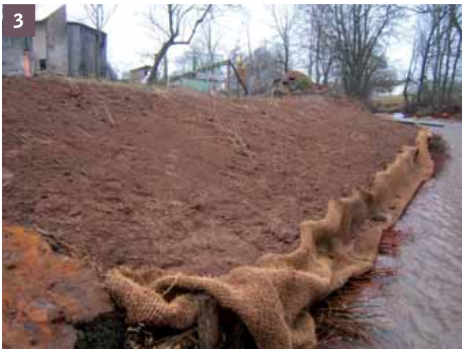
3 4 5 Physionomie pendant et juste après le recouvrement par une légère pellicule de terre sur les branches, par l'étalement des lés de géotextile et l'armature du talus
