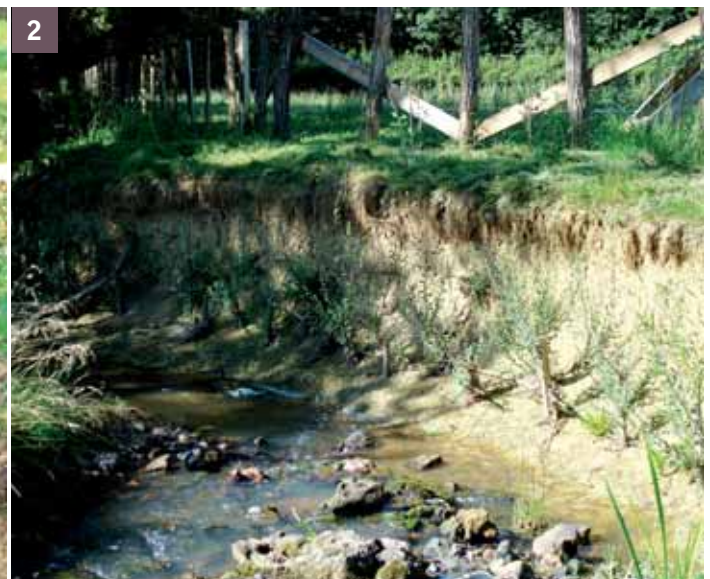
2 Reprise progressive des saules en pied du talus
