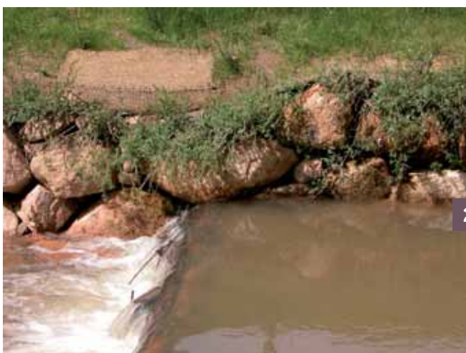
2 Reprise de la végétation intégrée à l'enrochement
