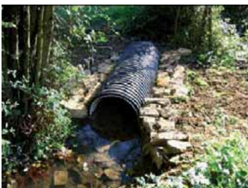
Arche en PEHD en cours d'installation
