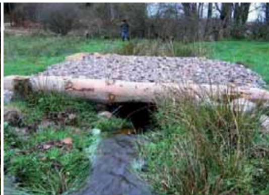
Passerelle bois et remblai de matériaux concassés
