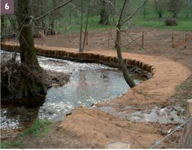
6 et 7 Physionomie de l'aménagement à la fin des travaux. Remarquez la technique qui est bien ancrée dans le talus en amont et en aval ramilles tournées vers l'aval
