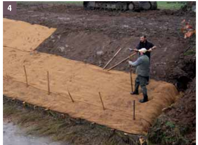
3 4 5 Physionomie pendant et juste après le recouvrement par une légère pellicule de terre sur les branches, par l'étalement des lés de géotextile et l'armature du talus
