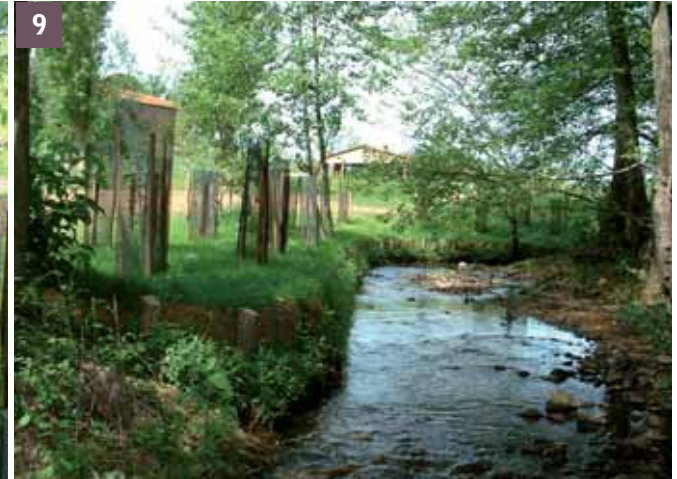
8 et 9 État d'un tressage de saules en pleine période de végétation juste après la fin des travaux
