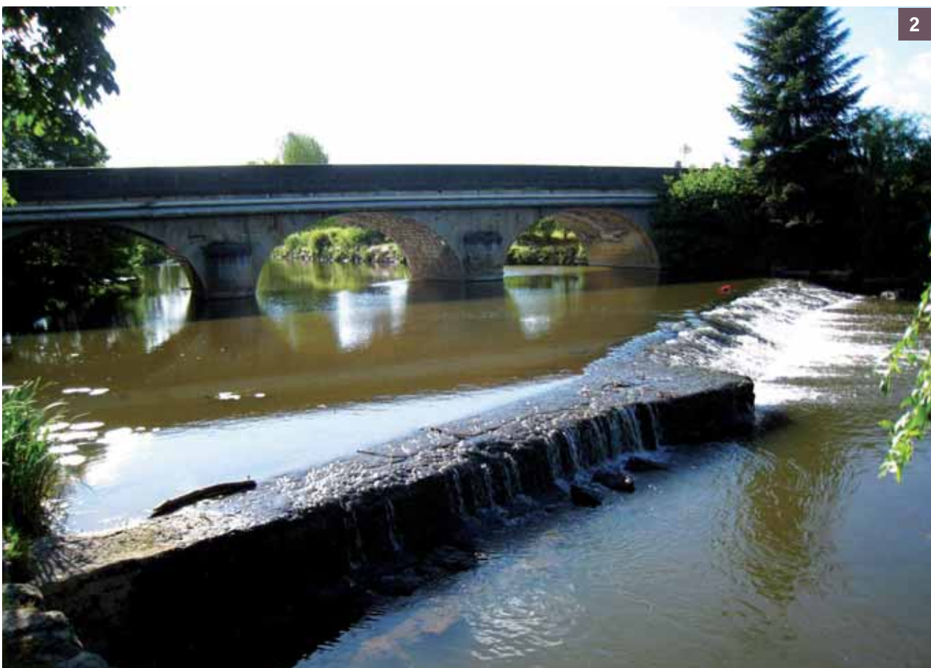
1 et 2 Surdimensionnement du lit, homogénéisation des faciès d'écoulement dans la retenue d'un seuil, début de développement d'algues et d'eutrophisation du milieu
