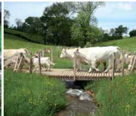
Passerelle bétail en bois
