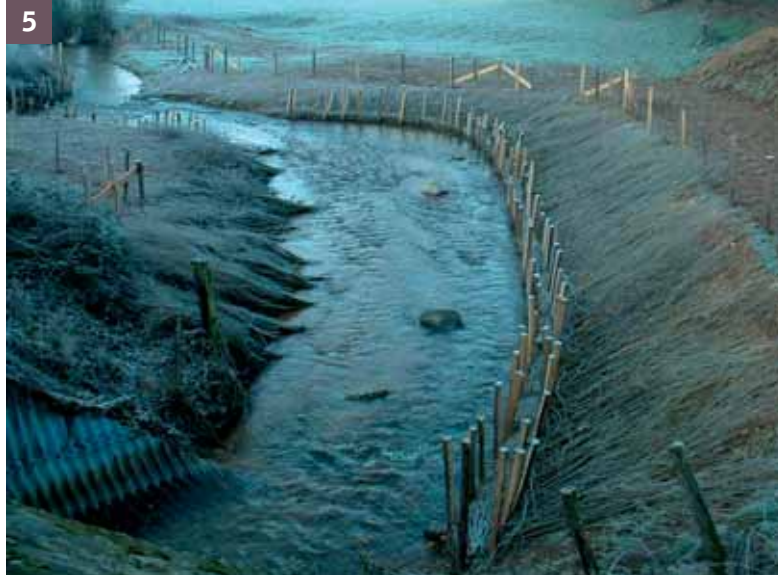
5 Option : en retrait, accompagnement ici de la fascine par un lit de branches à rejets sur le talus
