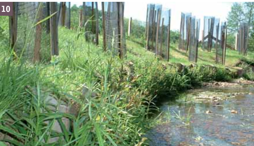
10 et 11 Reprise et apparition des premières tiges du tressage en façade et en crête de l'ouvrage
