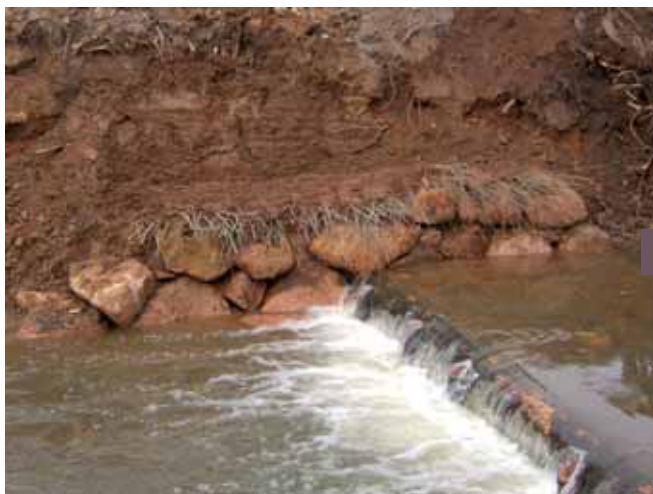
1 Ici mise en place d'un enrochement plongeant surmonté de 3 rangs de lits de plants et plaçons. Il est aussi accompagné en amont et en aval sur les parties moins contraintes par des fascines de saules et lits de branches à rejets
