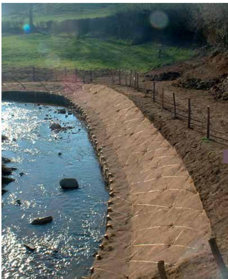
6 Physionomie de la berge après mise en œuvre du géotextile et de l'armature
