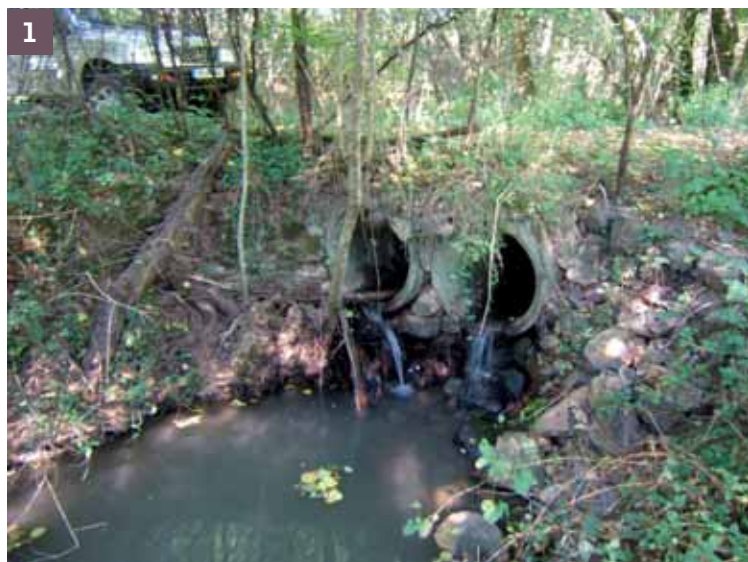
1 Buse ronde mal calée avec chute d'eau à l'aval infranchissable pour la faune aquatique
