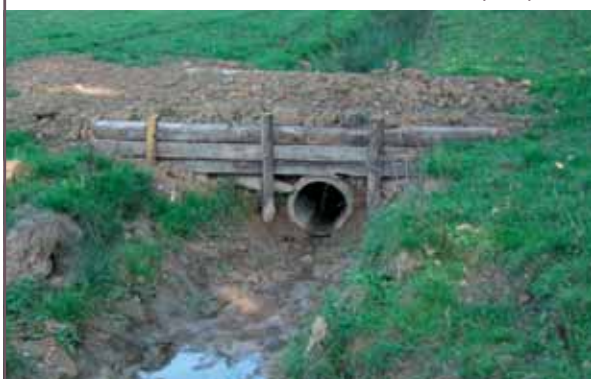
Accélération de l'écoulement = érosion des berges en aval et blocage des espèces aquatiques
