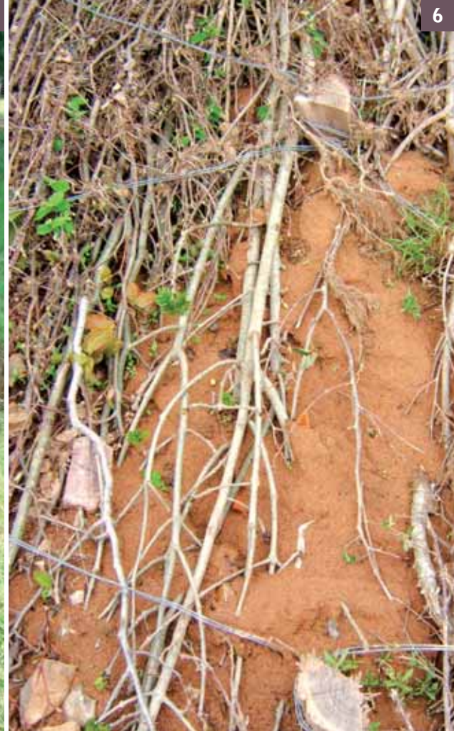
Peigne installé dans une encoche d'érosion sur le Bézo (5), blocage des sédiments (6) et reprise végétative immédiate le printemps suivant (7)
