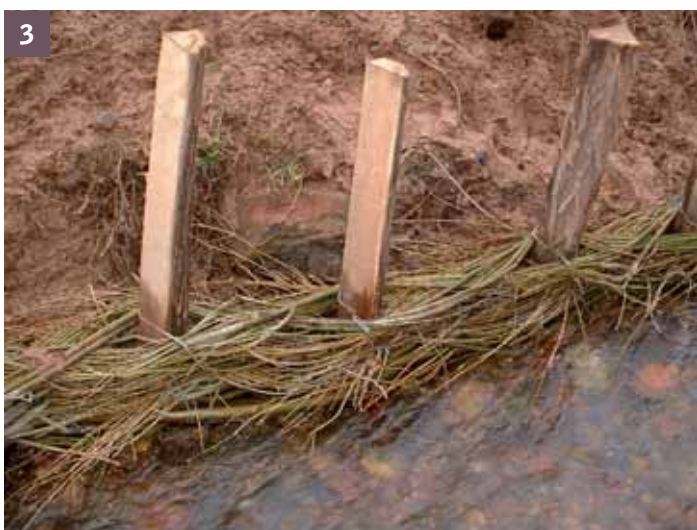
1 et 2 Tressage des branches de saules et ligaturage autour des pieux, La base des branches dirigée vers l'intérieur du talus, les extrémités des ramilles tournées vers l'aval
