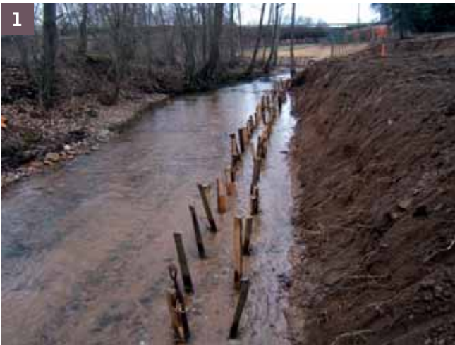
1 Réalisation d'une banquette en pied de berge et mise en place de la double rangée de pieux
