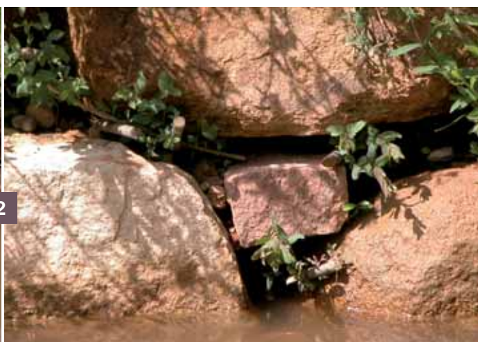
1 Ici mise en place d'un enrochement plongeant surmonté de 3 rangs de lits de plants et plaçons. Il est aussi accompagné en amont et en aval sur les parties moins contraintes par des fascines de saules et lits de branches à rejets
