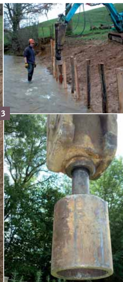
3 Installation et battage mécanique des pieux de la fascine - Cloche de battage montée sur brise roche de pelle
