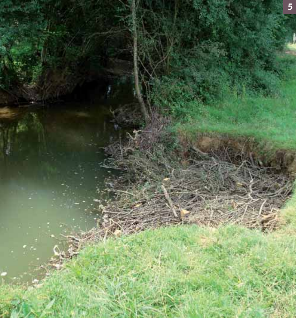
Peigne installé dans une encoche d'érosion sur le Bézo (5), blocage des sédiments (6) et reprise végétative immédiate le printemps suivant (7)
