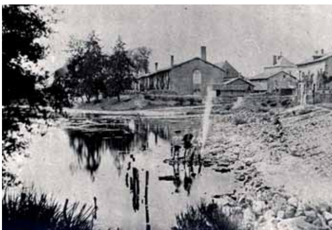
Seuil à Charlieu (seuil des pompiers)
