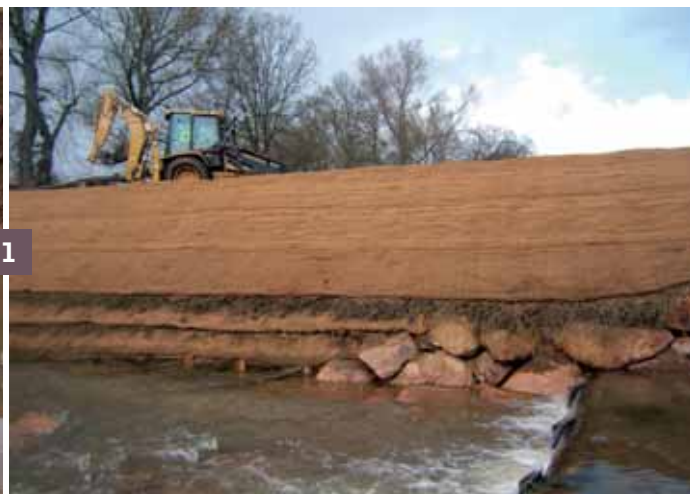
1 Ici mise en place d'un enrochement plongeant surmonté de 3 rangs de lits de plants et plaçons. Il est aussi accompagné en amont et en aval sur les parties moins contraintes par des fascines de saules et lits de branches à rejets
