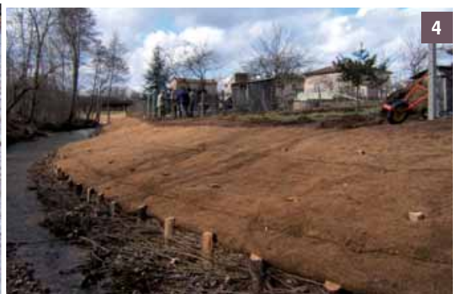
4 Le site en fin de travaux
