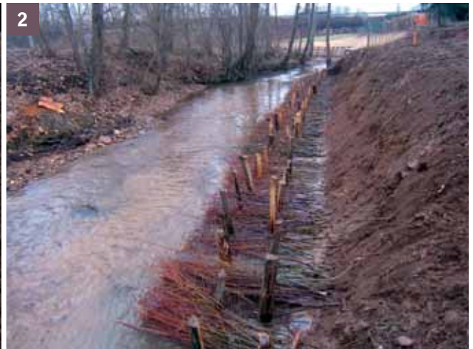
2 Mise en place ici d'un lit de branches anti-affouillement perpendiculaire au cours d'eau et avant l'arrivée de la fascine
