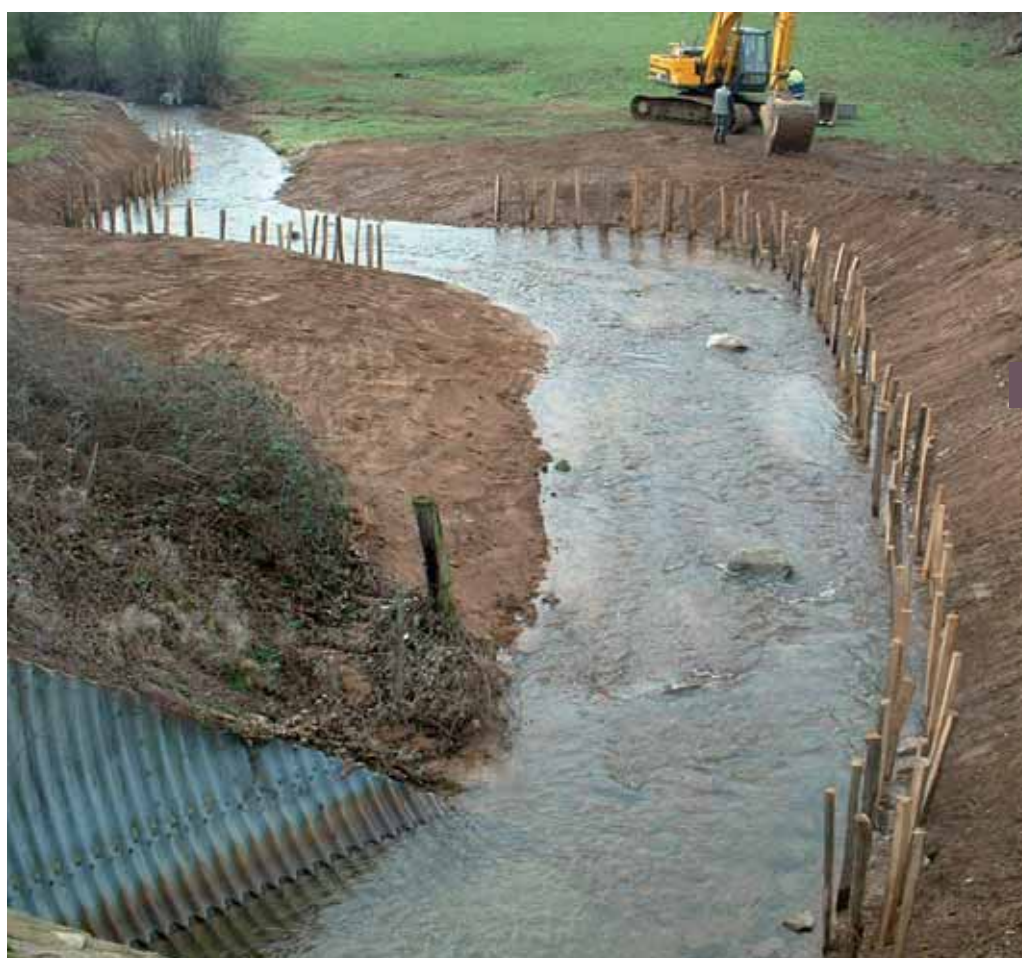
3 Installation et battage mécanique des pieux de la fascine - Cloche de battage montée sur brise roche de pelle
