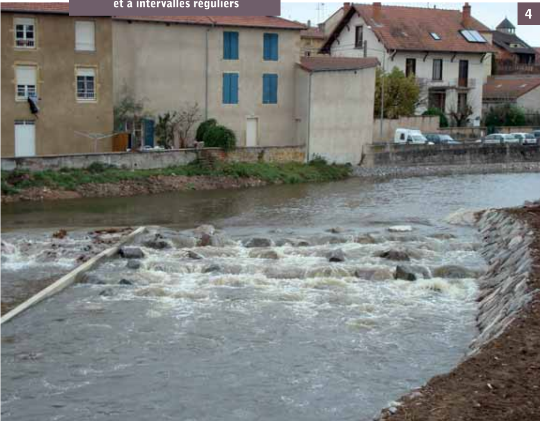
4 Ouvrage terminé, en eau
