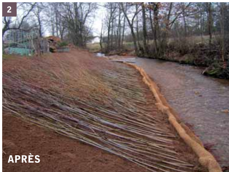
2 Après terrassement, installation d'une grande quantité de branches vivantes de saules sur le sol (extrémités des ramilles dirigées vers la partie haute du talus), enfouies en pied sous des matériaux terreux.
