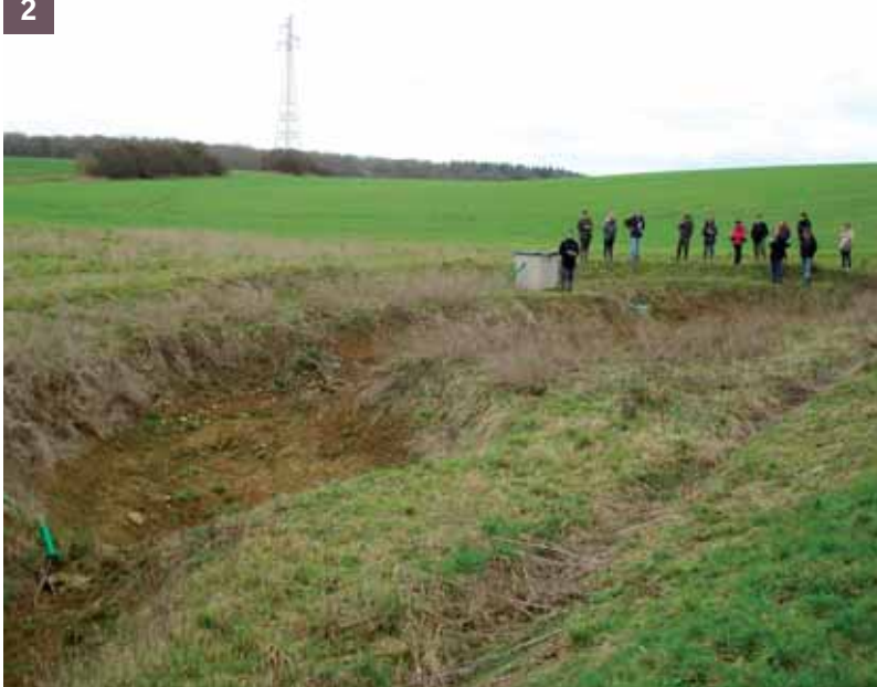
2 Ici aménagement dans la bande tampon réglementaire de 5 m, de trois bassins de décantation en sortie du dispositif de drainage et du collecteur principal. Les molécules polluantes sont fixées, les sédiments fins également.
