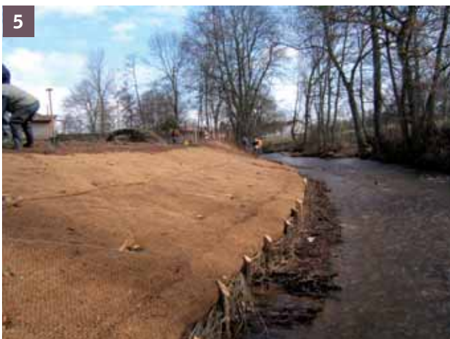
3 4 5 Physionomie pendant et juste après le recouvrement par une légère pellicule de terre sur les branches, par l'étalement des lés de géotextile et l'armature du talus
