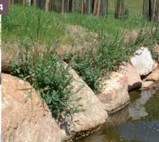
4 Reprise des boutures dans les interstices des blocs et du rang de plançons
