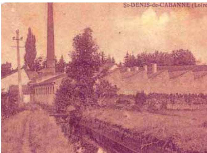
Béal d'alimentation d'une usine à St Denis-de-Cabanne
