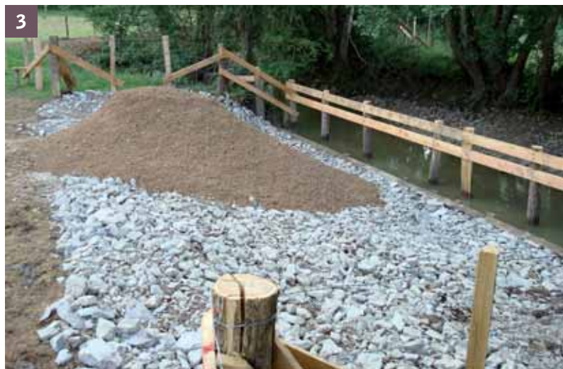
2 Terrassement, mise en place des longrines et des pieux
