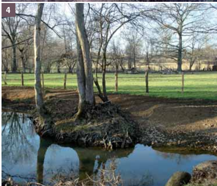
3 et 4 Piétinement et disparition progressive du sous-bois. Dans le meilleur des cas il ne restera petit à petit plus qu'une végétation malheureusement confinée en pied de berge
