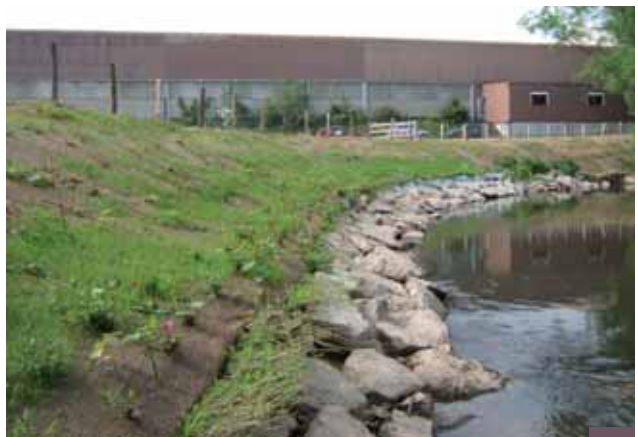
1 Mise en place d'un enrochement en pied de berge accompagné d'un seul rang de plants et plançons sur le dessus
