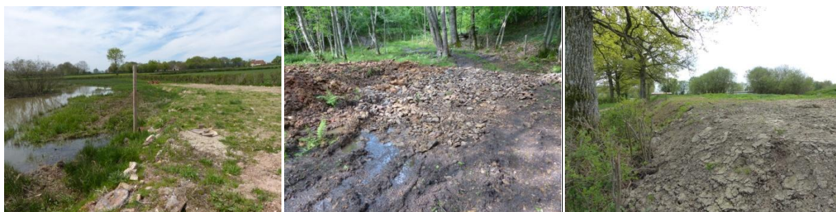
Figure 33 : Remblais en zones humides
