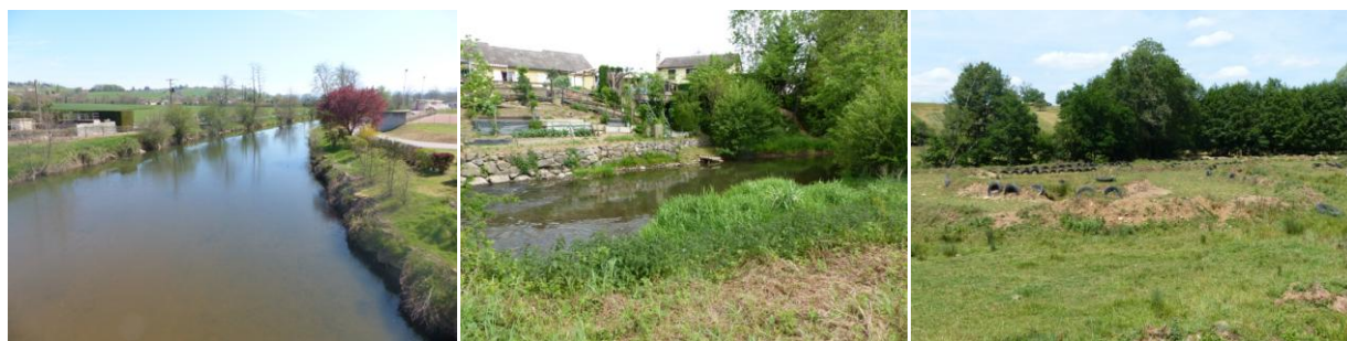
Figure 19 : Artificialisations du Sornin (endiguement à gauche, enrochement au centre) ; Aménagement d'un terrain de cross en prairie humide (à droite)
