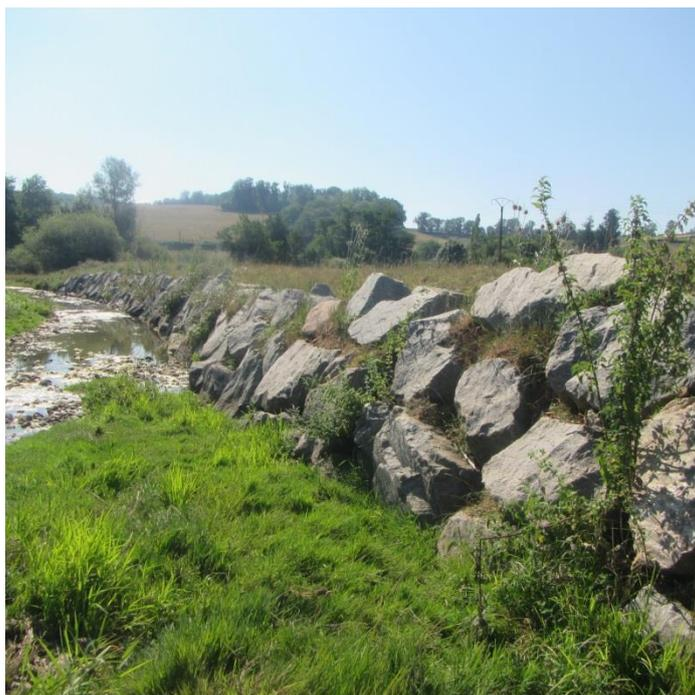
Figure 9 : Enrochements en protection de berge du talus amont – Photographie prise par ISL en juillet 2019
