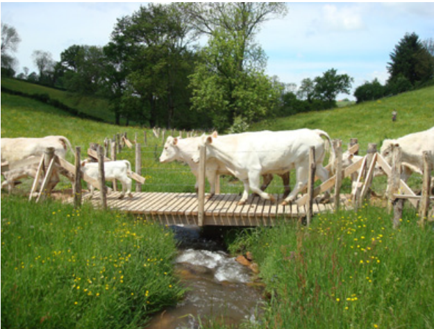
Figure 9 : Passerelle réalisée sur le Chandonnet
