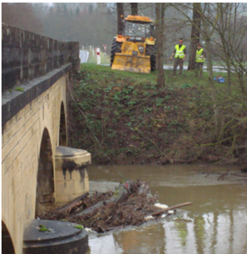
Figure 22 : Enlèvement d'un embâcle par l'équipe rivière sur le Sornin à Charlieu
