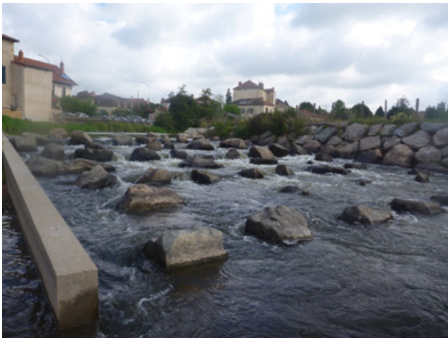
Figure 13 : Passe à poissons sur seuil des Pomptiers à Charlieu
