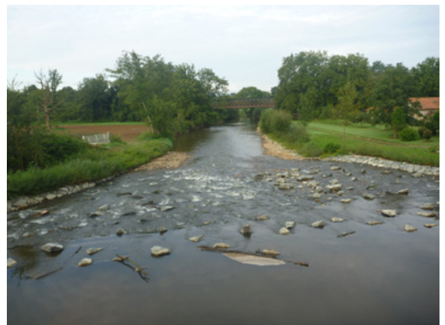
Figure 16 : Passe à poissons sur seuil de SB127 à Pouilly-sous-Charlieu
