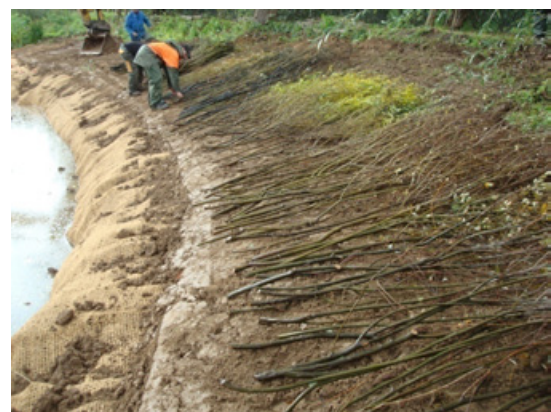
Figure 17 : Pose de lit de plans et plançons et fascinage sur l'amont du caisson
