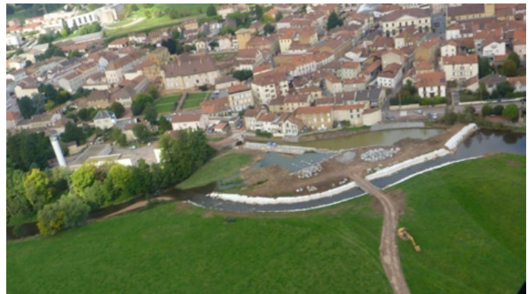
Figure 14 : Vue aérienne des travaux de restauration du seuil des Pomptiers
