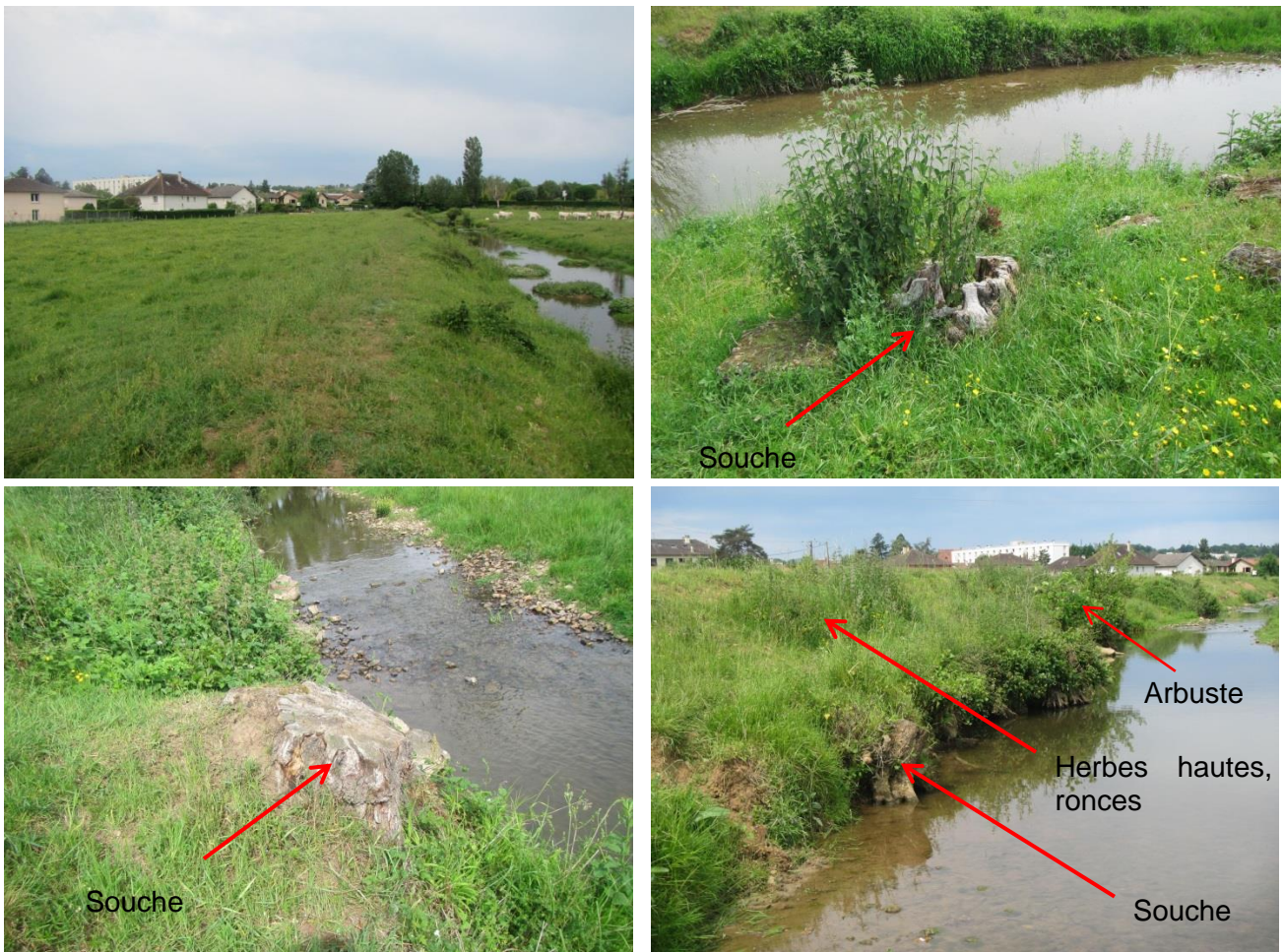
Figure 2-2 : Photographies de la digue du Bézou – ISL, le 3/06/2019
