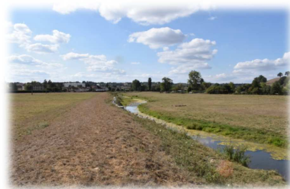
Vue aval de T4
