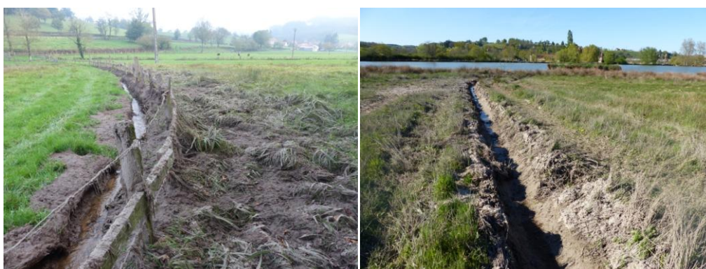
Figure 65 : Fossé assez profond (en haut à gauche) ; rigole superficielle (en haut à droite)
