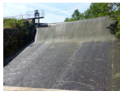
Prélèvements d'eau et Activité hydroélectrique, barrage
