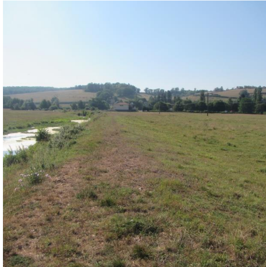
Figure 21 - TH8 : couvert végétal
