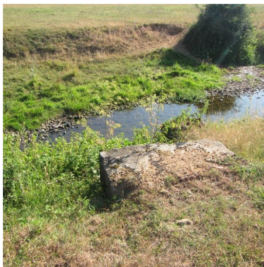
Figure 13 - TH5 : ouvrage singulier
