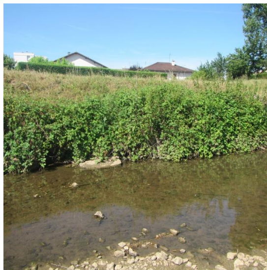
Figure 10 - Anse d'érosion sur le talus amont au TH3
