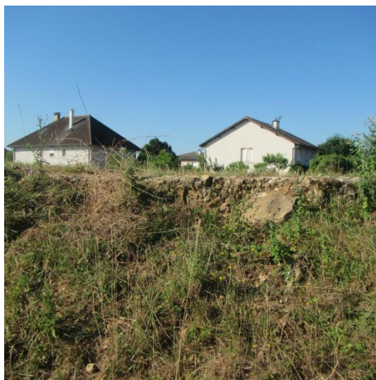
Figure 17 - TH6 : ouvrage singulier
