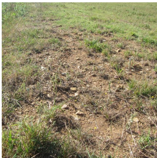
Figure 11 - TH4 : matériau constitutif de la digue
