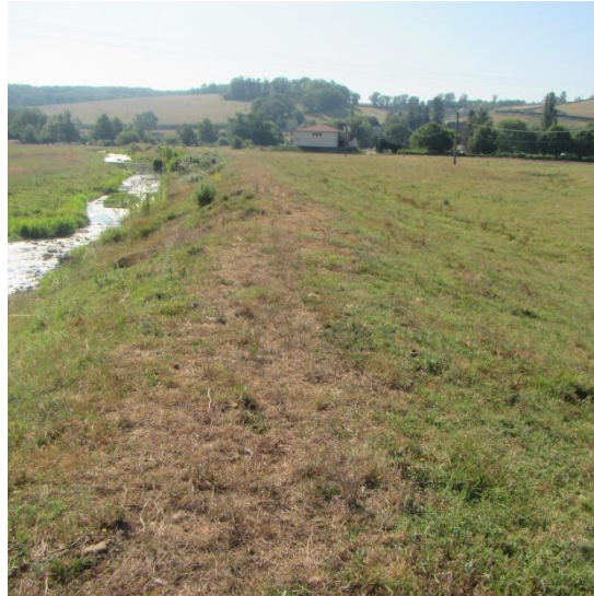
Figure 23 - TH9 : couvert végétal
