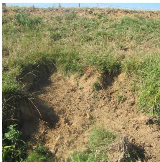
Figure 32 - Lentilles d'érosion aux TH7 et TH12
