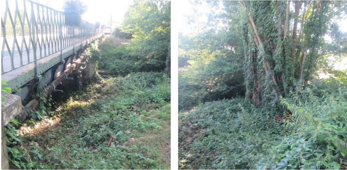
Figure 3 - TH1 : pont de la rue Jean Jaurès et atterrissement en talus amont
