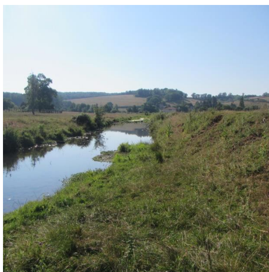
Figure 16 - TH6 : risberme en talus amont
