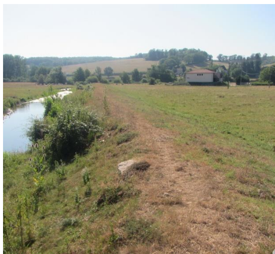
Figure 27 - TH10 : couvert végétal
