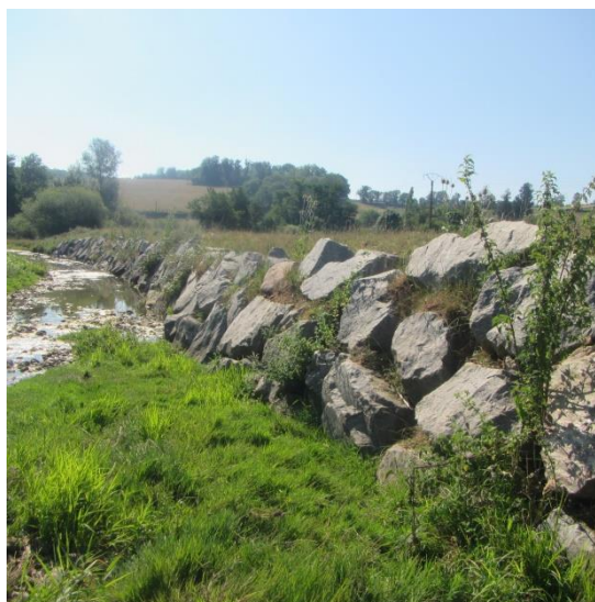
Figure 34 - TH14 : enrochements en talus amont
