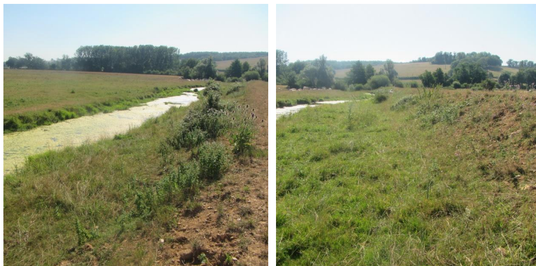
Figure 33 - TH13 : risberme en talus amont
