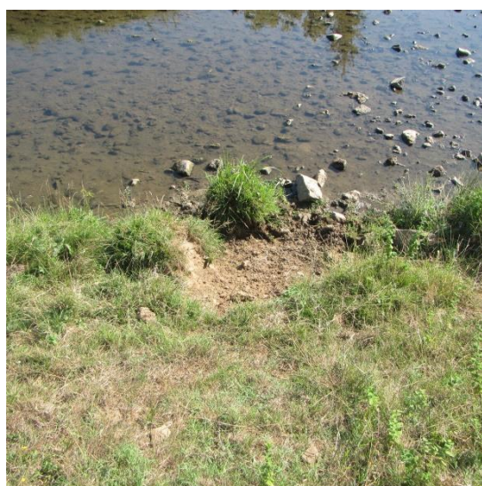
Figure 20 - Lentilles d'érosion aux TH7
