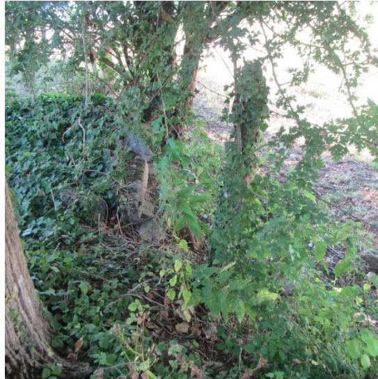
Figure 5 - TH1 : enrochements en talus aval
