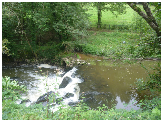
Figure 26 : Prise d'eau sur un ouvrage du Sornin médian
