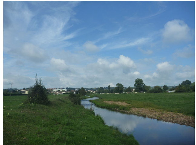
Figure 33 : Recalibrage et endiguement du Bézo à Charlieu
