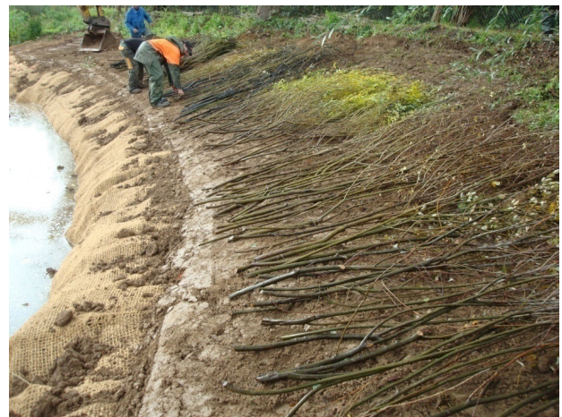
Figure 10 : Pose d'épis déflecteur et d'un lit plant et plançons au droit du camping de Charlieu
