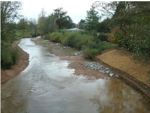
Figure 10 : Pose d'épis déflecteur et d'un lit plant et plançons au droit du camping de Charlieu
