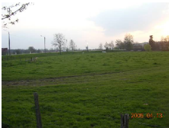
RD4 à Charlieu, érigée en remblai sur la plaine d'inondation du Sornin
