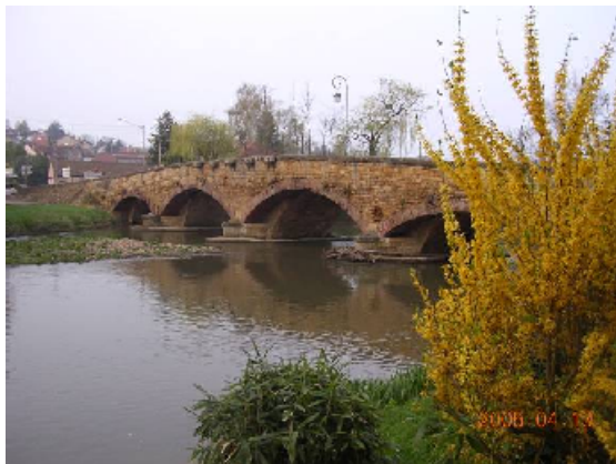
Le pont de Pierre à Charlieu atterrissement central à l'amont
