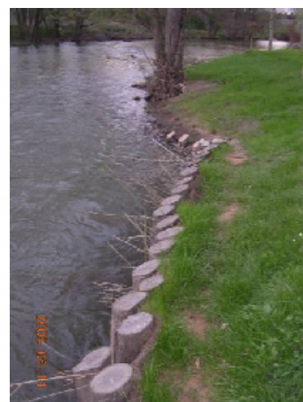
Moulin de Beauvernay Protection de la berge droite par génie végétal
