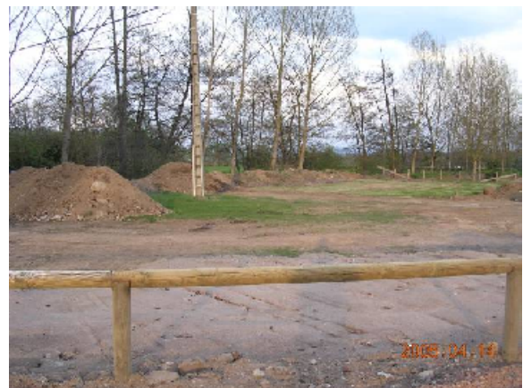
Camping de Pouilly Terrassements en cours
