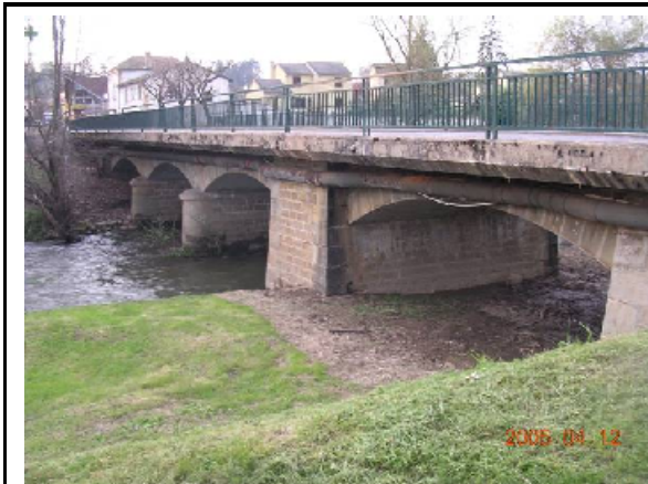
St Denis de Cabannes - Pont du Sornin la quatrième arche a été rajoutée après
