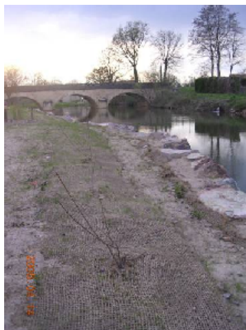
Pont de Pouilly La berge gauche devant le stade est protégée par des enrochements posés récemment
