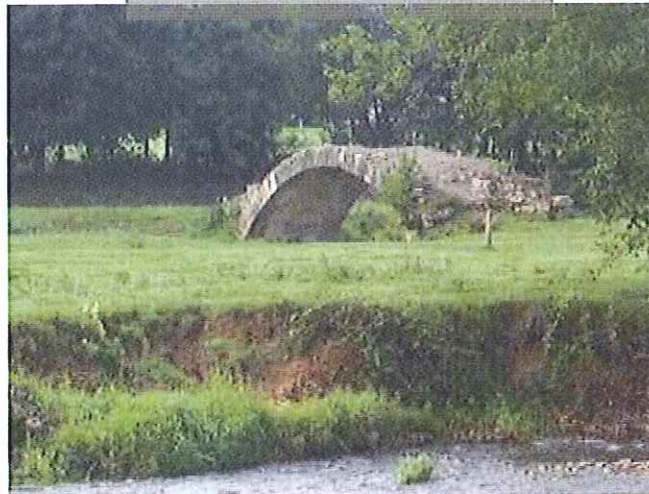
Pont à Pouilly-sous-Charlieu
