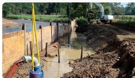
Pendant les travaux : batardeau
