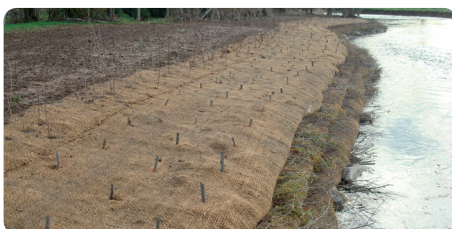
Fin des travaux
