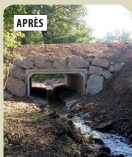
Pont cadre installé
