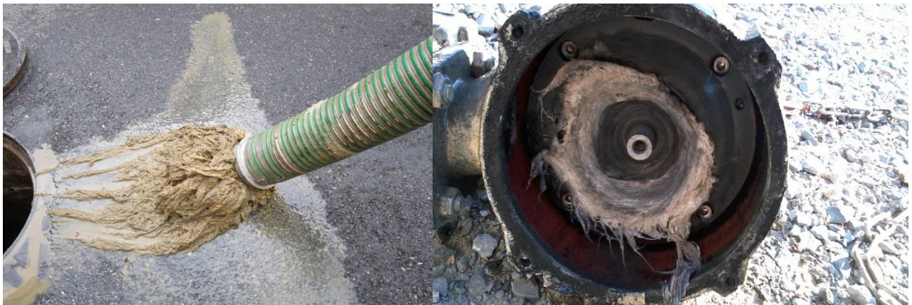
(Photo d'une extraction de bouchons liés aux lingettes, source : Fluks aqua)
