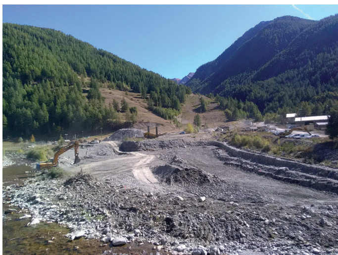
Travaux aménagement cône déjection Peynin – Aiguilles (CCGQ, oct. 2019)
