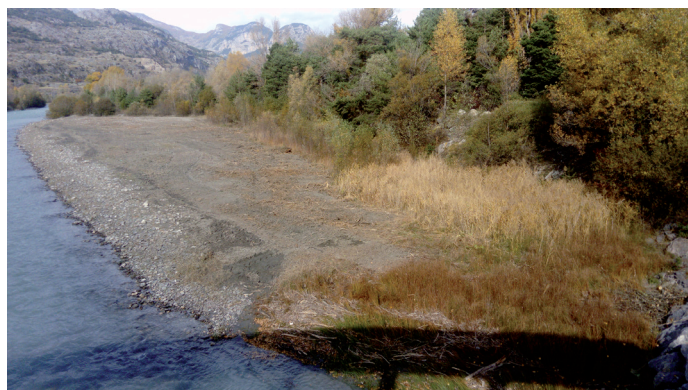
Traitement végétation bancs de la Durance à Chanteloube
