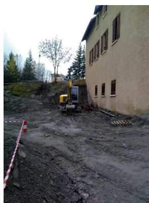
Terrassement des fondations d'extension du bâtiment
