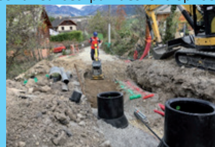
Chantier réseau le Villaret
