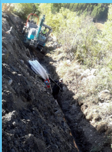
Chantier réseau des Casses
