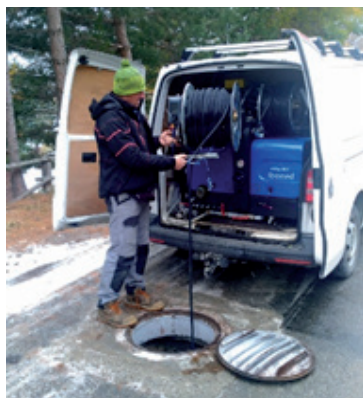
Opération d'hydrocurage par un agent de la régie d'Assainissement
