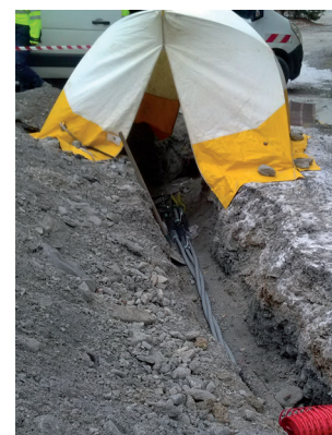
Déplacement ligne Haute Tension
