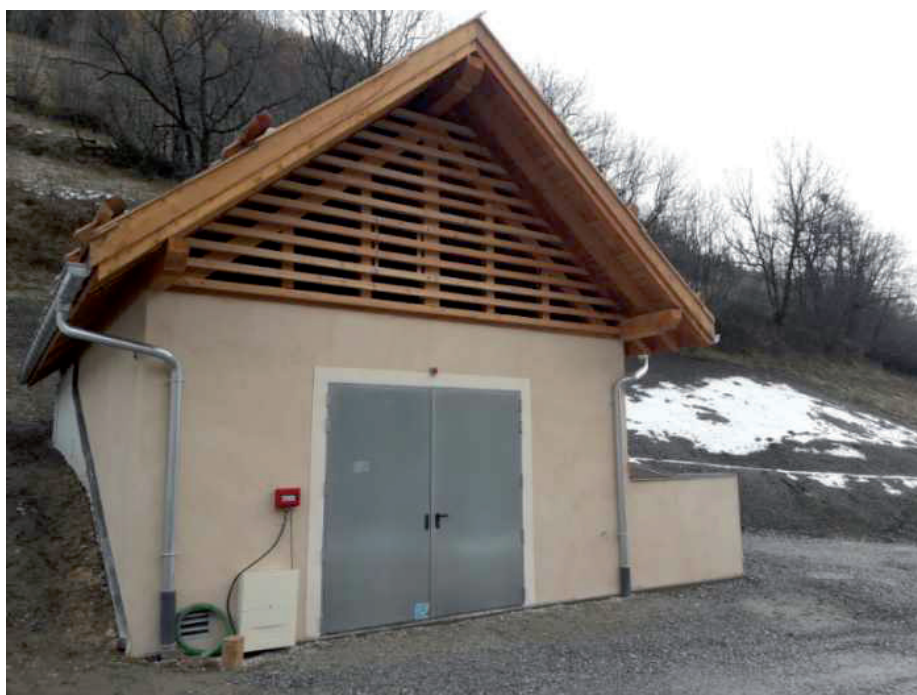
Chaufferie Bois à Arvieux
