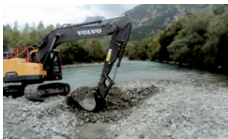
8 Ouverture d'un chenal sur l'îlot de Barrachin sur la Durance (CCGQ, 10.2020)
