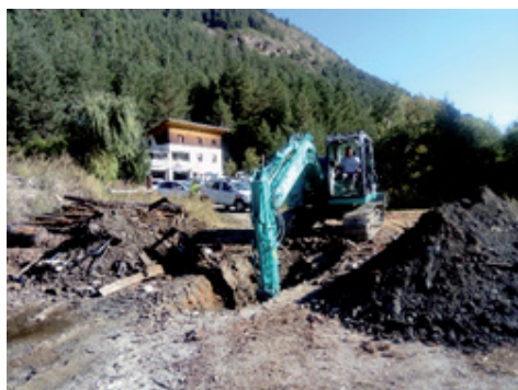
Sondages de l'ancienne décharge communale de Château-Ville-Vieille aux planissaux (CCGQ, sept. 2020)
