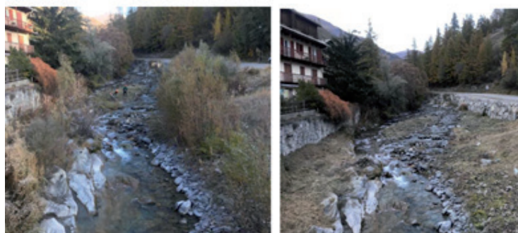
Avant et après entretien sur le Bouchet à Abriès (10.2020, Travaux & Environnement)
