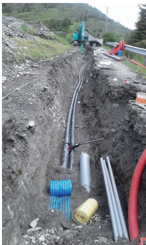
Chantier la Condamine
