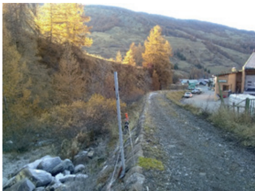
Digue de protection du Chagnon en amont du bourg de Sainte-Marie (CCGQ, Nov. 2020)
