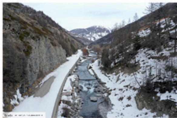
Tronçon du Guil au Gouret (Aiguilles) retenu au projet de restauration (vue aérienne, AMETEN Déc. 2020)
