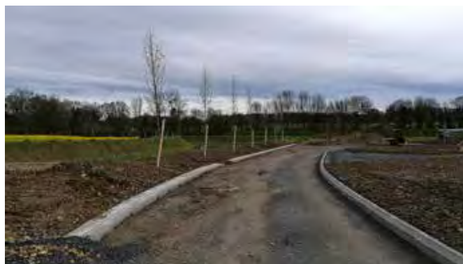
Travaux de la ZA la Loge à Azay-le-Rideau
