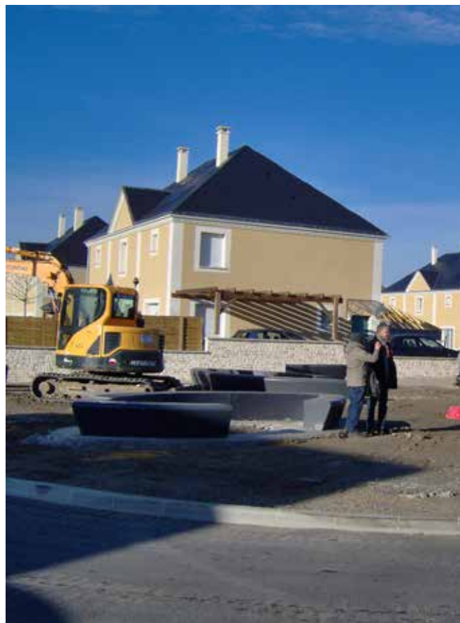
Travaux de la ZAC des Gués à Veigné
