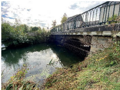
Pont-de-Ruan - Nettoyage Vannes Moulin
