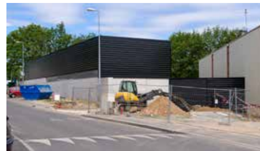
Construction d'une salle à Artannes-sur-Indre
