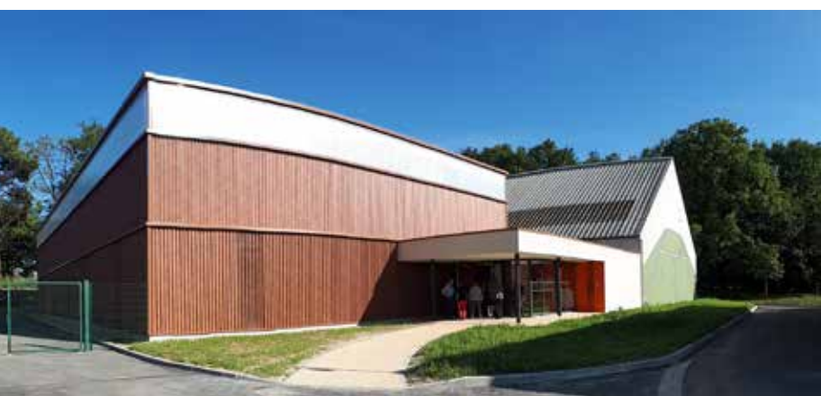
La salle de Monts est en service depuis 2017
