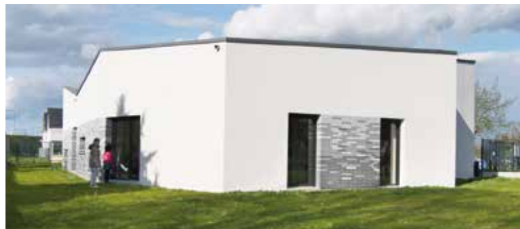
Nouvel ALSH - Truyes ouvert depuis septembre 2018
