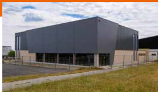
Extension en cours du gymnase d'Azay-le-Rideau
