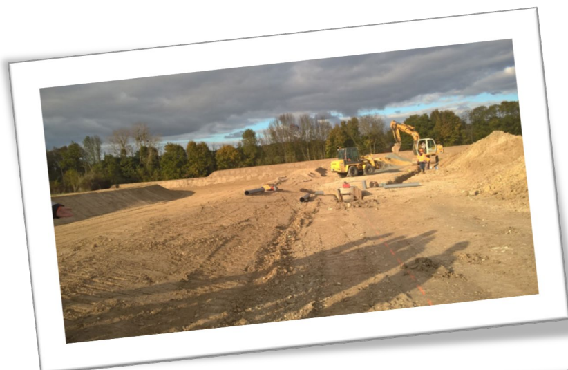
Travaux dans la ZAC de la Loge
