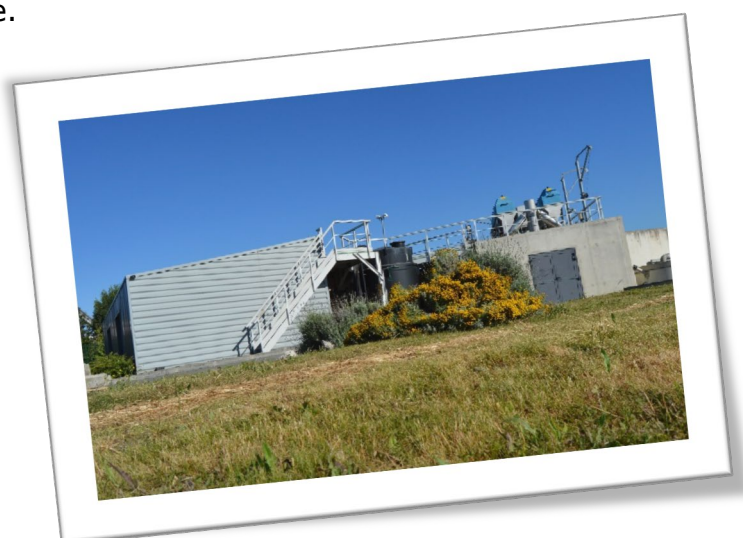
Station d'épuration ISOPARC
